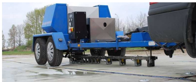
Rys. 3. Badanie nośności układu konstrukcyjnego ugięciomierzem HWD
