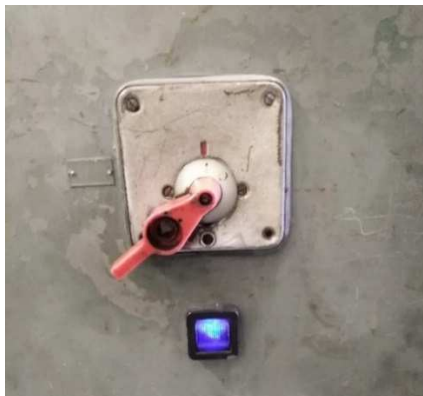
Rys. P12.1. Niesprawny wyłącznik główny
