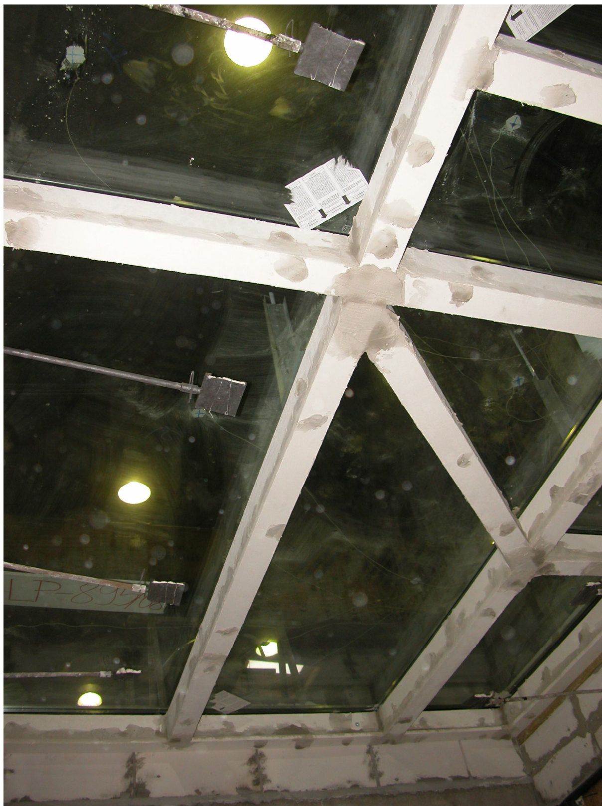
Rys. 1. Widok dachu przeszklonego od strony nienagrzewanej przed badaniem
