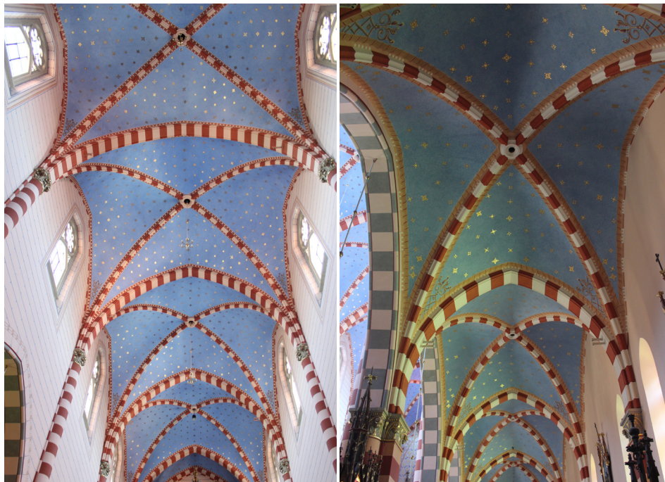
Fot. 79. Przemyśl – salezjanie. Kościół. Sklepienie nawy głównej
