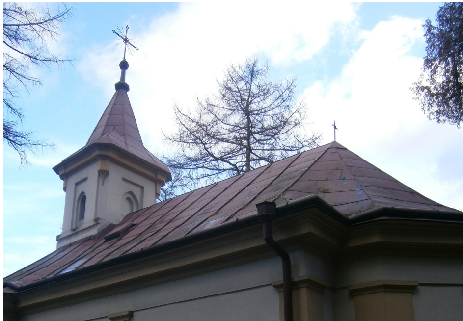
Fot. 3. Przemyśl. Kaplica na Cmentarzu Głównym. Pokrycie dachu
