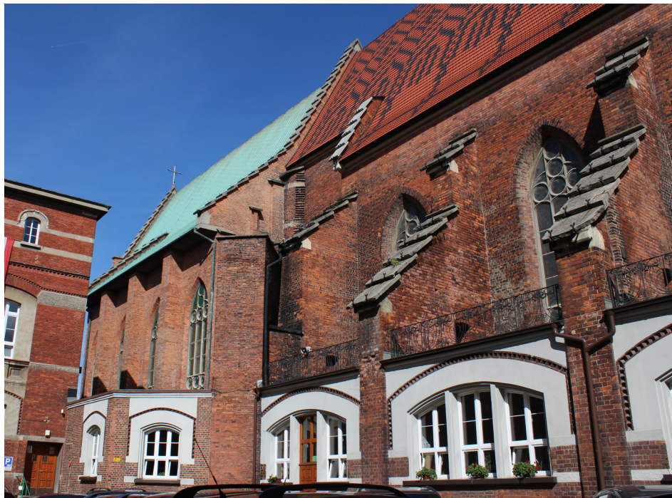
Fot. 99. Oświęcim – salezianie. Południowa elewacja kościoła, widoczny fragment niskiego szesnastoboku
