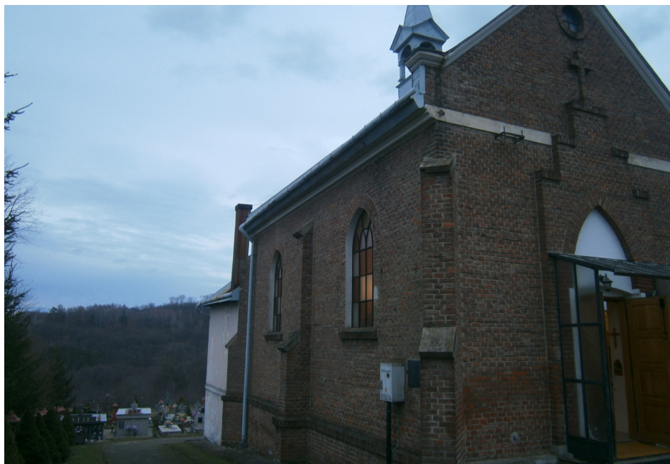
Fot. 25. Przemysł-Kruhel Wielki. Kościół. Usytuowanie budowli
