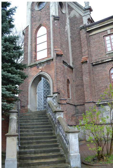
Fot. 65. Przemyśl – karmelitanki bose. Kościół. Schody przed głównym wejściem
