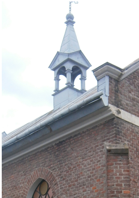
Fot. 30. Przemysł–Kruhel Wielki. Kościół. Gzyms koronujący
