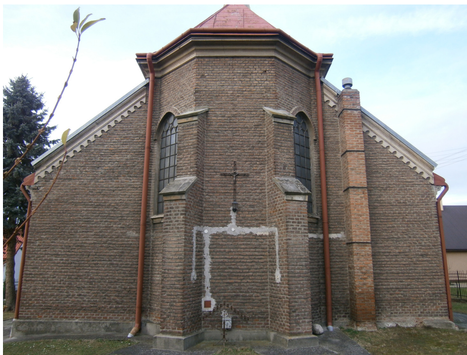
Fot. 43. Przemyśl–Pikulice. Kościół. Prezbiterium – widok od południa
