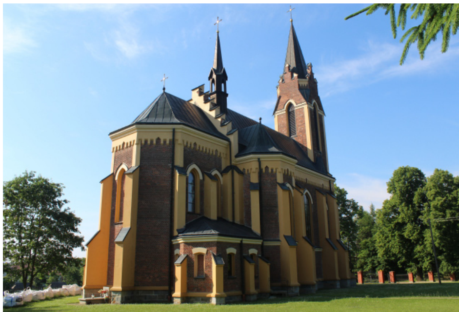
Fot. 92. Lutowiska. Kościół. Widok od strony prezbiterium
