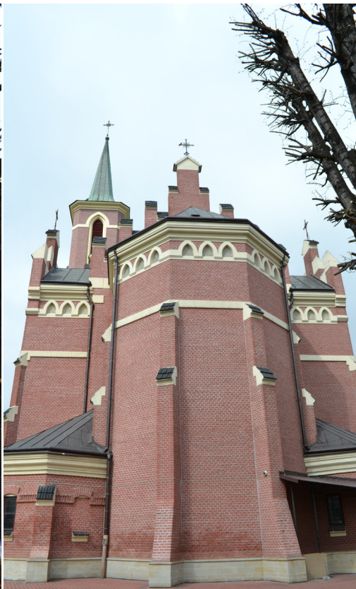
Fot. 56. Przemyśl-Błonie. Kościół. Prezbiterium – widok od wschodu
