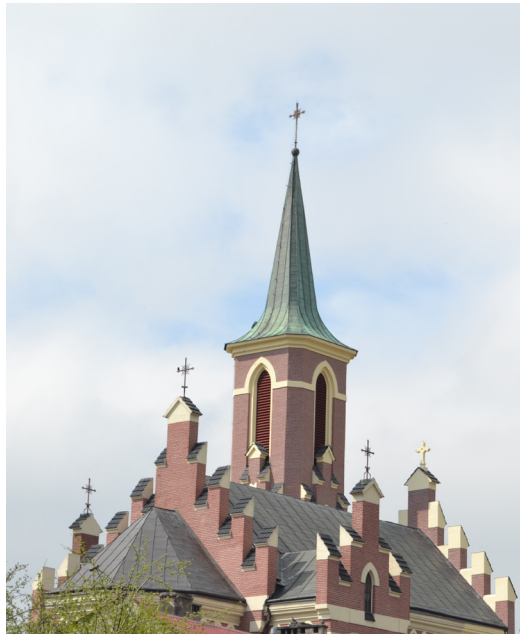
Fot. 57. Przemyśl-Błonie. Kościół. Pokrycia dachowe świątyni
