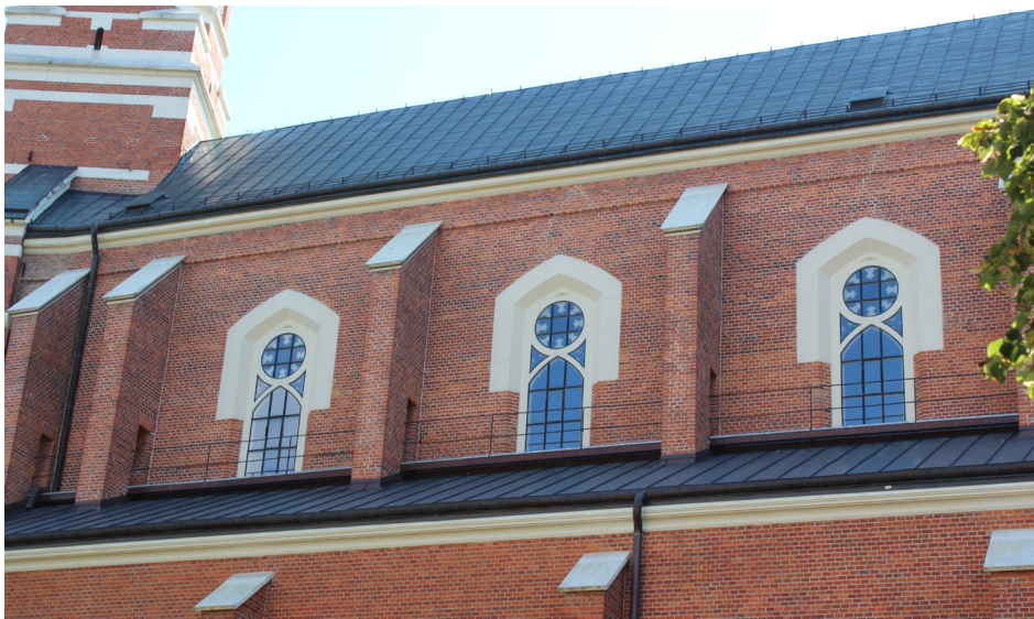
Fot. 77. Przemyśl – salezjanie. Kościół. Dachy nad nawami
