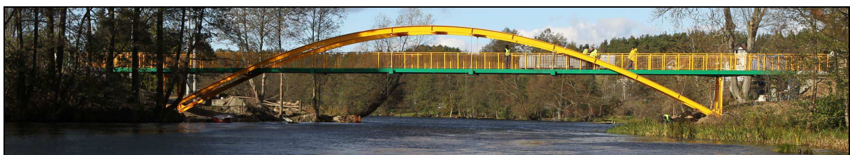
Rys. 1. Widok badanej kładki dla pieszych przez rzekę Brdę
