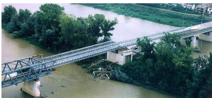
Rys. 7. Odbudowa mostu w starej osi na rzece Savie w miejscowości Brcko [9]
