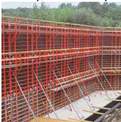
Fot.1 Deskowanie ramowe TRIO z pomostami tradycyjnymi [4]
