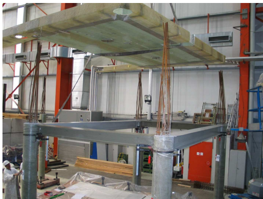
Rys 1. Wspólnotowe Centrum Badawcze EC (JRC-EC), Ispra. Badania prototypu kompozytowej płyty strop. do stosowania na terenach sejsmicznych, projekt SAFEFLOOR FP5 2001–2004 (fot. Acciona Infraestructuras)
