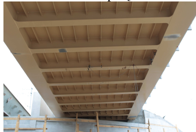
Rys.4. Widok od spodu konstrukcji przęsa w torze nr 102
