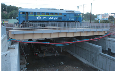
Rys.1. Widok ogólny przęsa w torze nr 501 Próbne obciążenie obiektu
