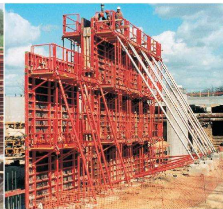
Fot. 2 Deskowanie ramowe TRIO z pomostami systemowymi [4]
