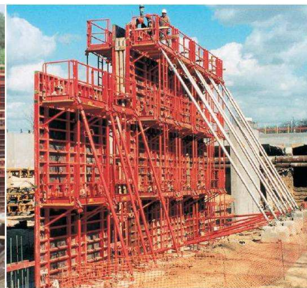
Fot. 2 Deskowanie ramowe TRIO z pomostami systemowymi [4]
