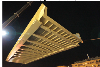
Rys.2. Widok od spodu konstrukcji przęśla w torze nr 501 Faza wstawiania przęśla
