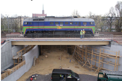
Rys.3. Widok ogólny przęśla w torze nr 102 Próbne obciążenie obiektu
