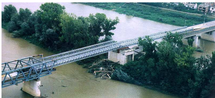
Rys. 7. Odbudowa mostu w starej osi na rzece Savie w miejscowości Brcko [9]
