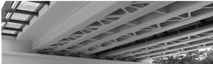
Rys. 1. Wiadukt KNI 140 070. Widok od dołu na belki główne i stężenia
