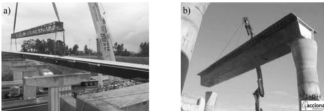
Rys. 1. a) budowa pierwszego kompozytowego wiaduktu w Hiszpanii (2004); b) montaż kompozytowego przęsła wiaduktu w ciągu autostrady M-111, w Madrycie (2008); źródło: Acciona Infraestructuras.
