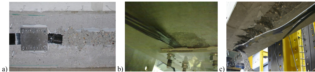
Rys. 4. Belki po zniszczeniu a) P3 - zakotwienie czynne), b) P6 - wysunięcie taśmy, c) P4 - odspojenie taśmy
