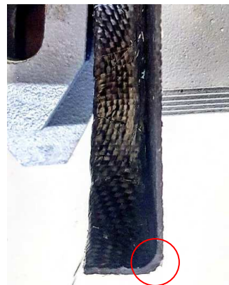
Rys. 14. Prawidłowo wykonany promień przejścia
