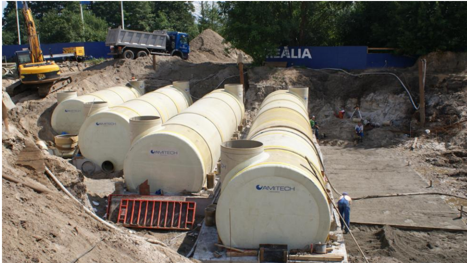
Rys. 1. Zbiorniki rurowe w układzie równoległym [5]
