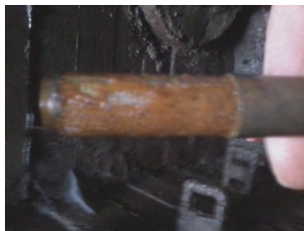
Rys. 20. Zanieczyszczony filtr samoczyszczący
