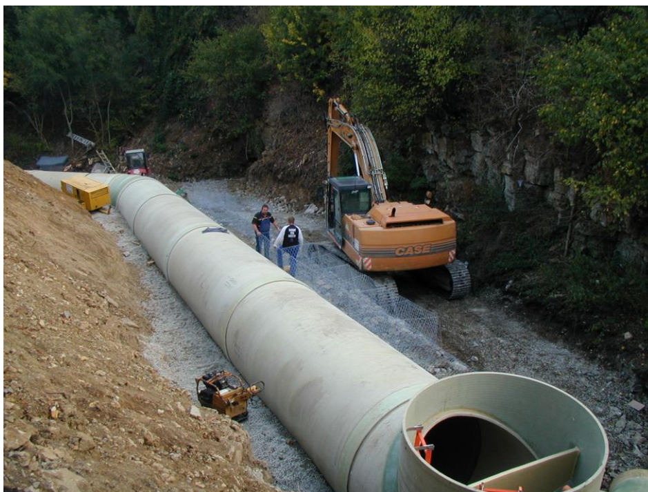
Rys. 2. Zbiorniki rurowe w układzie liniowym [5]
